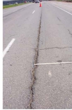
Longitudinal Crack
