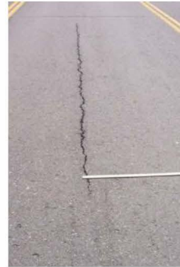
Longitudinal Crack
